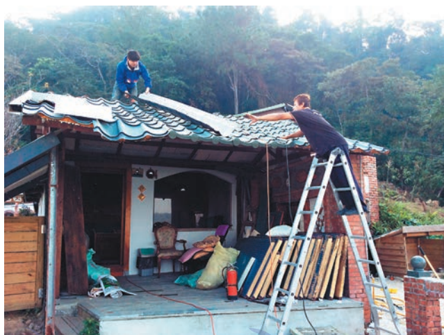
▲義工努力進行山莊屋頂的汰舊換新工程。
